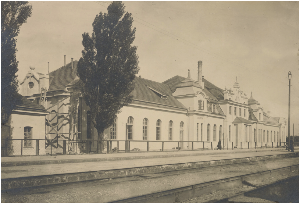
7. Stacja kolejowa Wołkowysk Centralny, widok elewacji dworca od strony peronu przed 1925 r. Źródło: Dyrekcja K.P. w Wilnie. Wydział Drogowy. Odbudowa dworców, domów mieszkalnych i wież ciśnieni. Dla dyrektora departamentu inż. J. Mrozowskiego, [1925]; Biblioteka Narodowa, sygn. F11798/AFF.III-44 Wołkowysk Central train station, view of station elevation from a platform, prior to 1925; source: Dyrekcja K.P. w Wilnie. Wydział Drogowy. Odbudowa dworców, domów mieszkalnych i wież ciśnieni. Dla dyrektora departamentu inż. J. Mrozowskiego [1925]; National Library, call no. F11798/AFF.III-44
