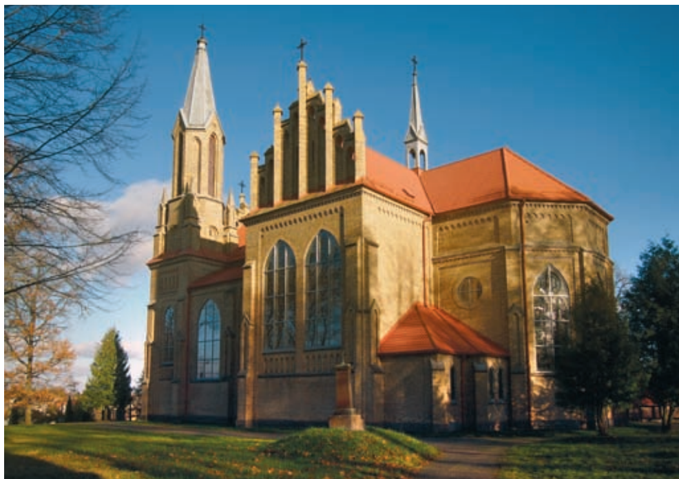
Krynki, widok kościoła parafialnego pw. św. Anny. Fot. A. Kułak. Krynki, view from the St. Anne parish church. Photo: A. Kułak.
