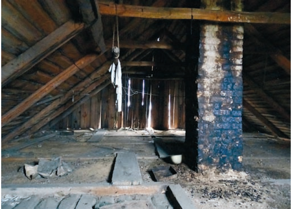
13. Poddasze nieużytkowane z widokiem na nieszczelną ścianę. Unused attic with a view of a non-airtight wall.
