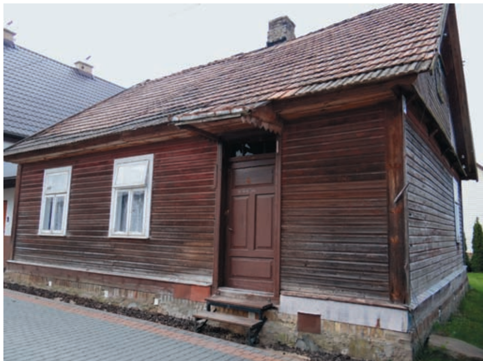
1. Olmnty. Dom nr 48. Wszystkie fotografie A. Depczyńska, 2017. Olmnty. House no. 48. All photos: A. Depczyńska, 2017.
