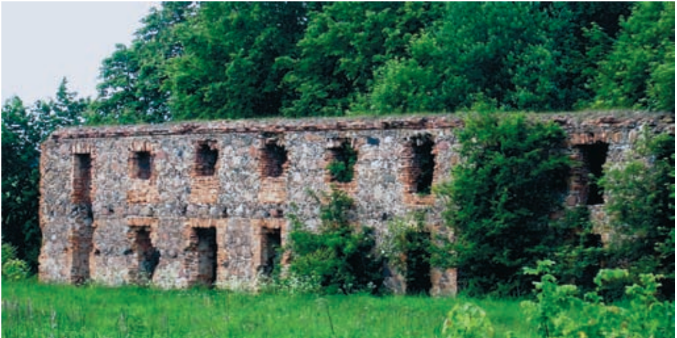
16. Krynki. Park dworski. Ruiny dawnego spichlerza z XVIII wieku – widok na ścianę południową.
