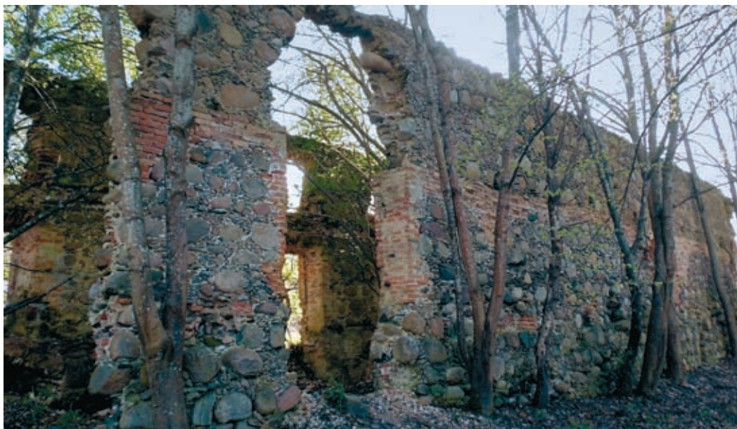
17. Krynki. Ruiny dawnego spichlerza – widok na ścianę północną. Fot. C. Bach-Szczawińska, 2018. Krynki. Ruins of the old granary – view of north wall. Photo: C. Bach-Szczawińska, 2018.
