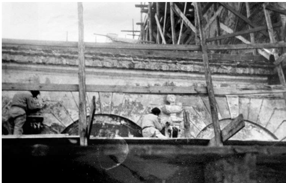
51. Prace konserwatorskie przy popiersiach na elewacji lewej galerii pałacu (por. il. 19, 20). WUOZ w Białymstoku, nr intw. M/17/1511/2.
