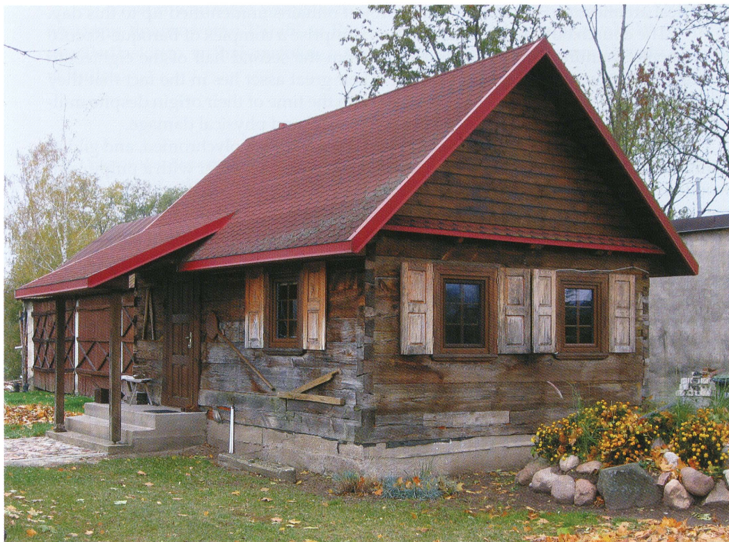
1. Widok domu na działce nr 39. Fot. Karolina Bernacka, 2016. View of house on lot 39. Photo: Karolina Bernacka, 2016.
