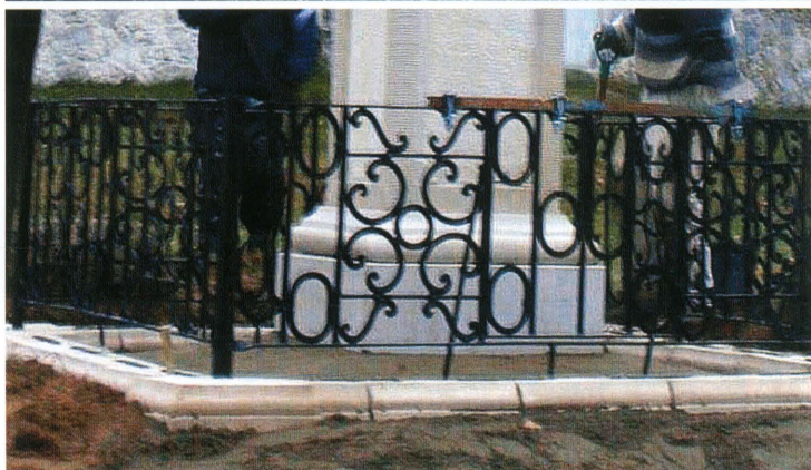
17-18. Ogrodzenie przed i po konserwacji. Fencing prior to and after conservation.
