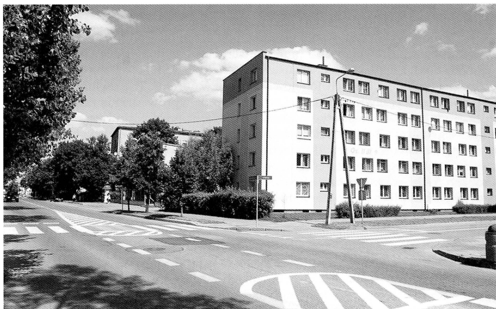
22. Zabudowa wzdłuż ul. T. Noniewiczza, stan z 1953. Fot. z dokumentacji: Krystyna Ciborowska, Studium historyczno-urbanistyczne , 1953 (maszynopis ze zbiorów Wojewódzkiego Urzędu Ochrony Zabytków w Białymstoku, Delegatura w Suwałkach).
