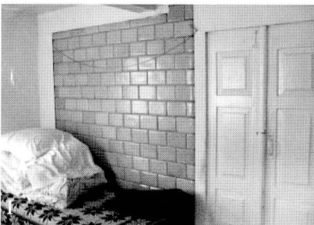
11. Ścianki grzewcze (ścianówki). A. Bogdanki w gm. Juchnowiec. B. Chomontowce w gm. Gródek. C. Topolany w gm. Michałowo. D. Mieleszki w gm. Gródek. E. Żywkowo w gm. Zabłudów. F. Dorozki w gm. Juchnowiec. G. Ostrów Południowy w gm. Krynki. H. Mierzwin Duży w gm. Wyszki. I. Knyszewicze w gm. Szudziałowo. J. Deniski w gm. Bielsk Podlaski. Fot. studenci W.A. P.B. Heating walls (ścianówki). A. Bogdanki, commune of Juchnowiec. B. Chomontowce, commune of Gródek. C. Topolany, commune of Michałowo. D. Mieleszki, commune of Gródek. E. Żywkowo, commune of Zabłudów. F. Dorozki, commune of Juchnowiec. G. Ostrów Południowy, commune of Krynki. H. Mierzwin Duży, commune of Wyszki. I. Knyszewicze, commune of Szudziałowo. J. Deniski, commune of Bielsk Podlaski. Photos: students from the Department of Architecture at the Białystok Polytechnic.
