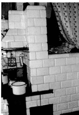
10. Szczegóły rozwiązań podlaskich systemów piecowych. A. Leżak podsufitowy łączący piece, we wsi Słoja w gm. Szudziałowo. B. jw., ale we wsi Wojszki w gm. Juchnowiec. C. jw., ale we wsi Żółtki w gm. Tykocin. D. Archaiczne umieszczenie wlotu pieca chlebowego nad płytą paleniskową, we wsi Plutycze w gm. Bielsk Podlaski (pod piecem zaś jest skrytka na drwa). E. Piec do wypieku chleba u dołu trzona piecowego, Koszele w gm. Orla. F. Zapiecek magazynowy (nie sypialny) we wsi Chomontowce w gm. Gródek. G. jw., ale we wsi Kotły w gm. Bielsk Podlaski. H. Fragment słupka grzejnego we wsi Chytra w gm. Hajnówka. Fot. studenci W.A. P.B. Details of solutions applied in Podlasie stove systems. A. Ceiling flue linking stoves in the village of Słoja, commune of Szudziałowo. B. Vide supra but also in the village of Wojszki, commune of Juchnowiec. C. Vide supra but also in the village Żółtki, commune of Tykocin. D. Archaic installation of a bread stove inlet above the plate in the village of Plutycze, commune of Bielsk Podlaski (a wood container is situated under the stove). E. Bread stove at the bottom of the stove core, Koszele, commune of Orla. F. Storage zapiecek (not used for sleeping) in the village of Chomontowce, commune of Gródek. G. Vide supra but in the village of Kotły, commune of Bielsk Podlaski. H. Fragment of a heating pillar in the village of Chytra, commune of Bielsk Podlaski.
