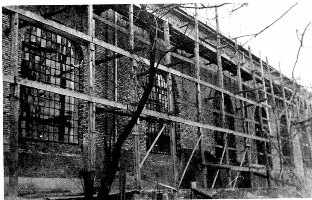
8. Odbudowa maszynowni, fot. z ok. 1945-46 r. Widać tu, że powtórzono dokładnie rytm i rozwiązania istniejące w obiekcie przed zniszczeniem. Repr. z Kroniki..., str. 55 Reconstruction of the engine room, photograph from about 1945-1946. The rhythm and solutions existing in the object prior to its destruction were copied precisely. Reprod. from Kronika..., p. 55
