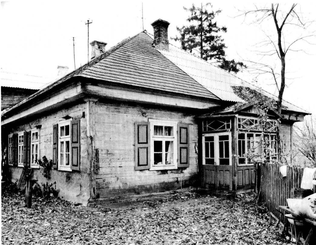
5. Szczyty-Nowodwory. Dwór. Elewacja północna. Fot. J. Szandomirski, 1975
